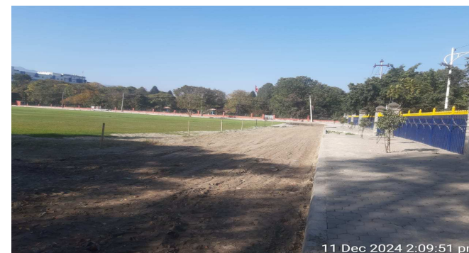
खुलामञ्च भित्र फुटपाथ निर्माण ।
